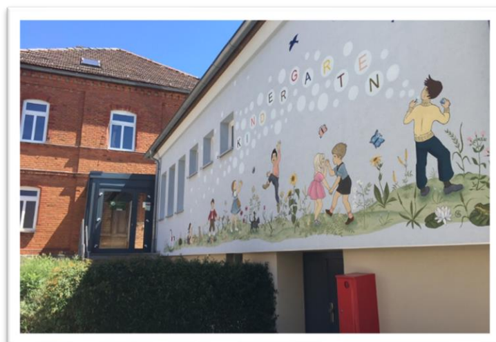
Abbildung 2: Außenansicht der Einrichtung
